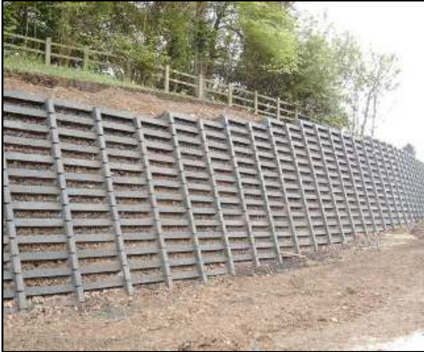
شکل ۱۱-۸ - نمونه‌ای از دیوار حائل صندوقه‌ای اجرا شده
