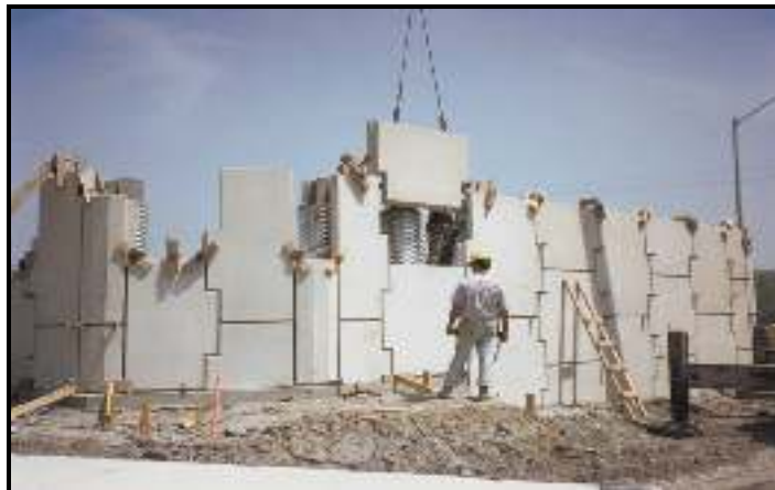
شکل ۱۲-۴- اجرای دیوار خاک مسلح با نمای بتنی
