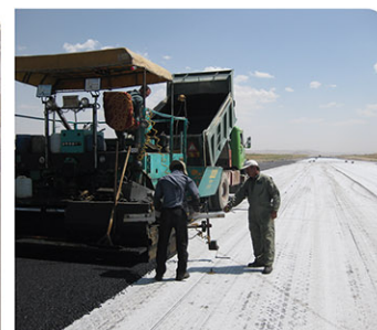
■ تقویت روکش آسفالتی باند فرودگاه سنندج ■ Asphalt overlay reinforcement of Sanandaj Airport Runway
