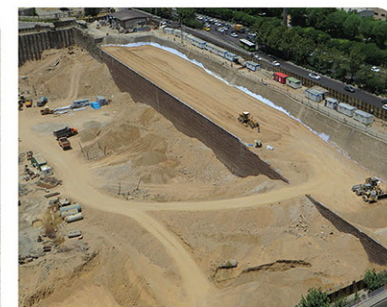
■ پایدارسازی دیواره های گود برج های دولتی، شرکت مخابرات ایران ۱۳۶۶ ■ Deep excavation walls stabilization, TCI twin towers, Tehran
