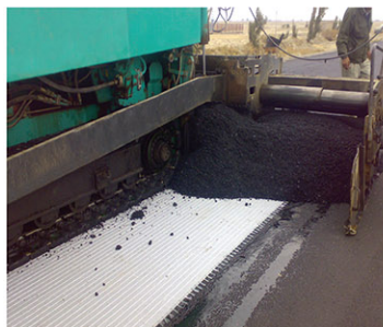
■ اجرای ژئوگرمیت آسفالتی از راه تهران - ساوه ■ GPC Asphalt_Geocomposite Installation, Tehran-Saveh Freeway
