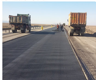
■ اجرای ژئوگرید آسفالتی آزاد راه مظفر - اسفهان ■ GP Grid Asphalt implementation
