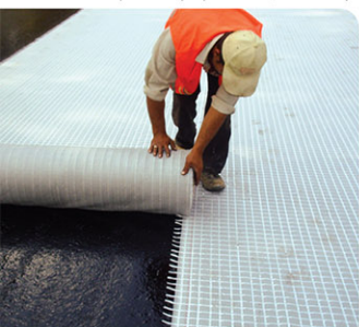
■ تقویت روکش آسفالتی باند فرودگاه دزفول ■ Asphalt overlay reinforcement of Dezful Airport Runway
