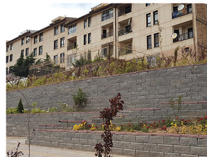
■ دیوار حائل ژئوگریدی، شهر جدید پردیس ■ Geogrid reinforced retaining wall, Pardis new town
