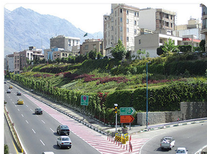
■ دیوار حائل بزرگراه شهید چمران، ۱۳۸۸ ■ Shahid Chamran highway geogrid soil reinforced retaining wall, Tehran
