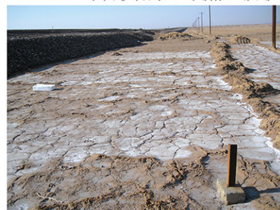
■ تقویت بستر با استفاده از ژئوگرید در احداث - خطوط جدید راه آهن قم-گرمسار
