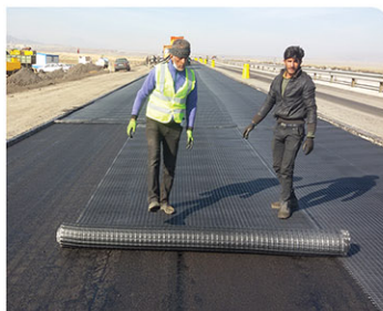
■ تقویت روکش آسفالتی شهرداری کنارگذر اسلامشهر ■ Asphalt overlay reinforcement Eslamshahr Bypass
