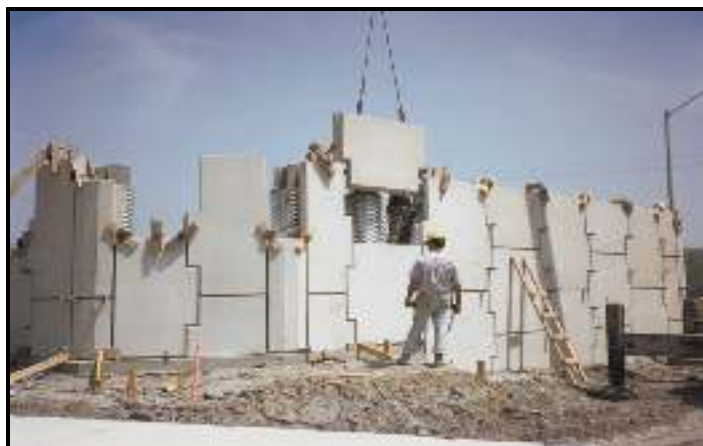
شکل ۱۲-۴- اجرای دیوار خاک مسلح با نمای بتنی
