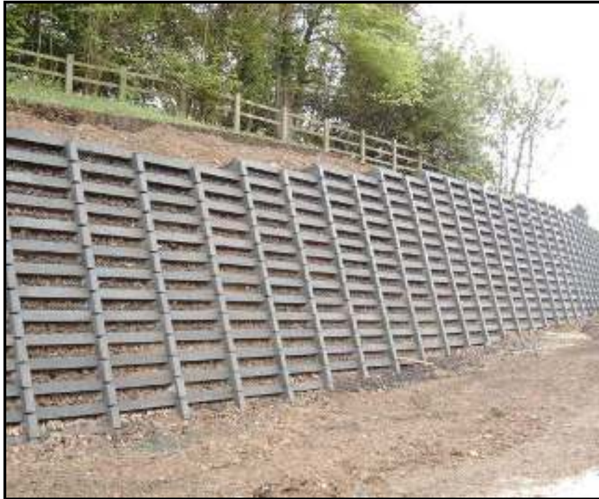
شکل ۱۱-۸ - نمونه‌ای از دیوار حائل صندوقه‌ای اجرا شده
